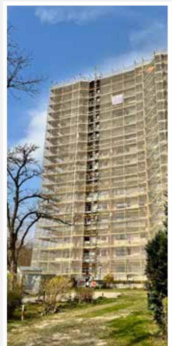
Eingerüstetes Hochhaus am Lichterfelder Ring 111
